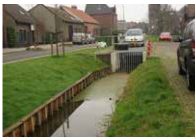
De inlaat van de overkluising ter plaatse van de Eiermarkt.
