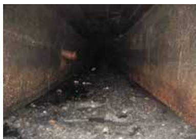
De betonnen koker van binnen.
